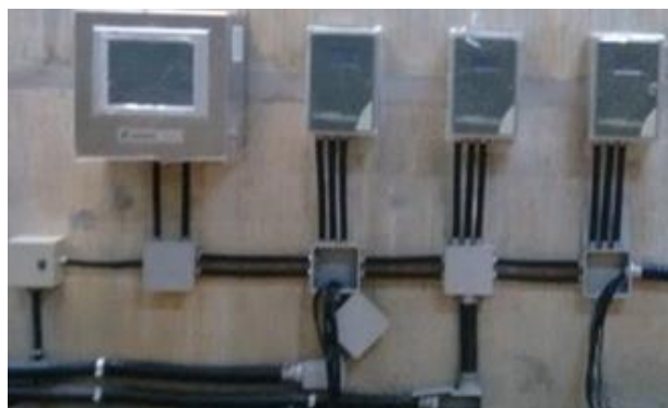
Figura 14 – Medidores de vazão instalados, em fase de acabamento. Fonte: Acervo próprio
