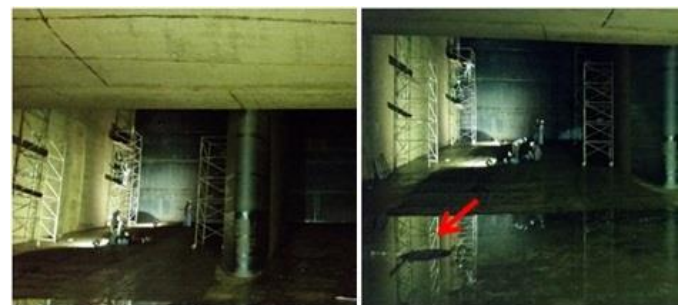
Figura 10 – Bifurcação de saída do tubo de sucção e grelha de escoamento. Fonte: Acervo próprio
