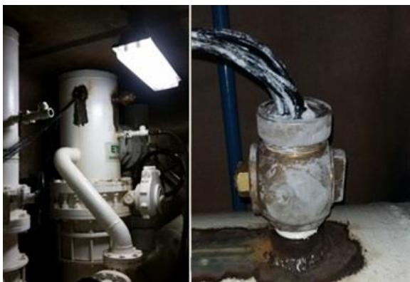
Figura 12 - Transposição de cabos e vedação da válvula. Fonte: Acervo próprio
